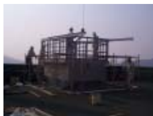
工事のようす
