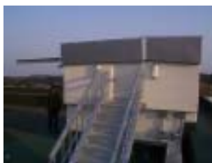
<完成> 屋根が閉じています
