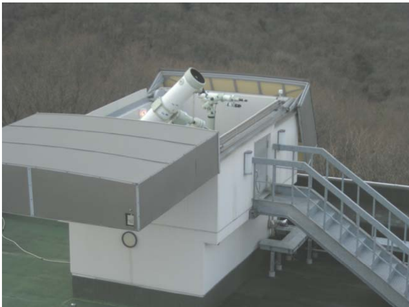
図2-1 宮教大天文台ルーフ開放時の様子（9号館屋上）。2台並んでいる望遠鏡のうち、中型望遠鏡（手前）を金星ライブ用で運用、小型望遠鏡（奥）を月ライブ用で運用している。
